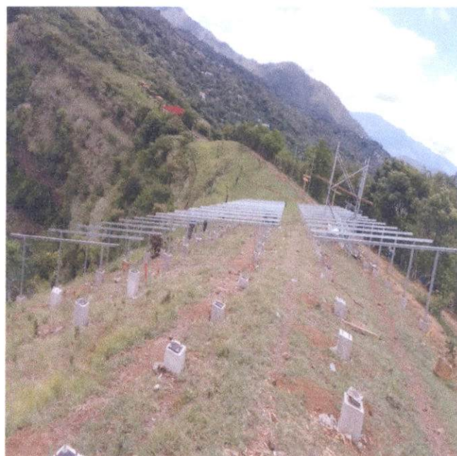
Fotografías: Estructura metálica para los paneles solares anclados a las bases
