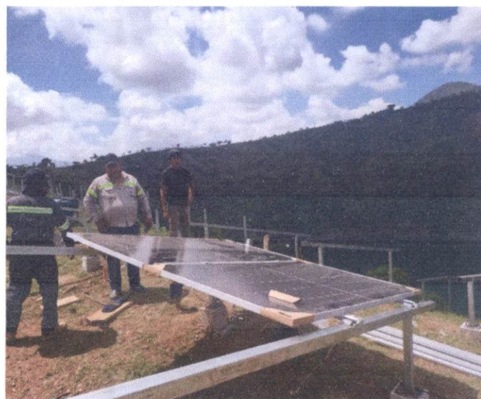
Fotografías: instalación de Paneles Solares
