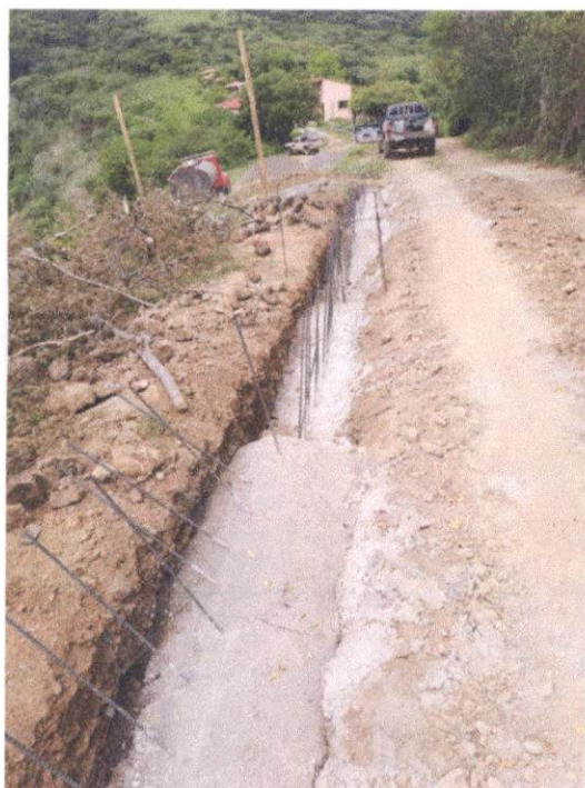
Cimiento corrido para muro perimetral y base para inversores
