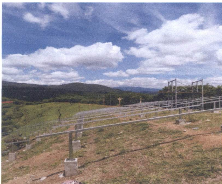
Fotografías: Estructura metálica para los paneles solares anclados a las bases
