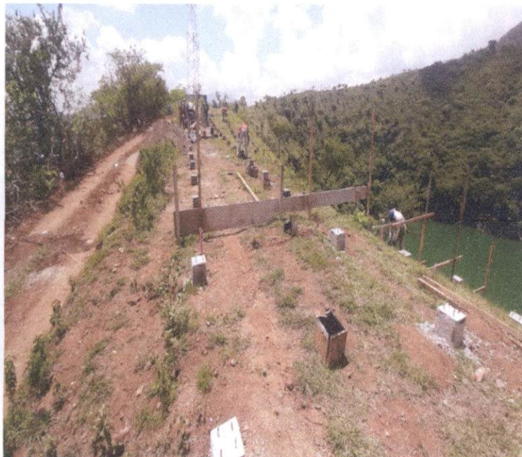
Fotografías bases o columnas de en donde se anclará la estructura metálica de los paneles solares Renglón: Sistema Fotovoltaico
