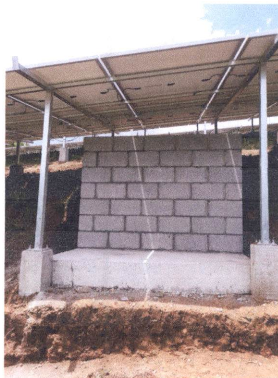
Cimiento corrido para muro perimetral y base para inversores
